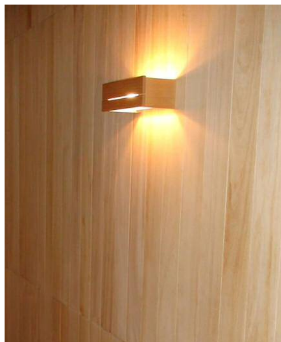
階段桐壁 : 厚12×幅150×長1820mm 自然塗料塗装
