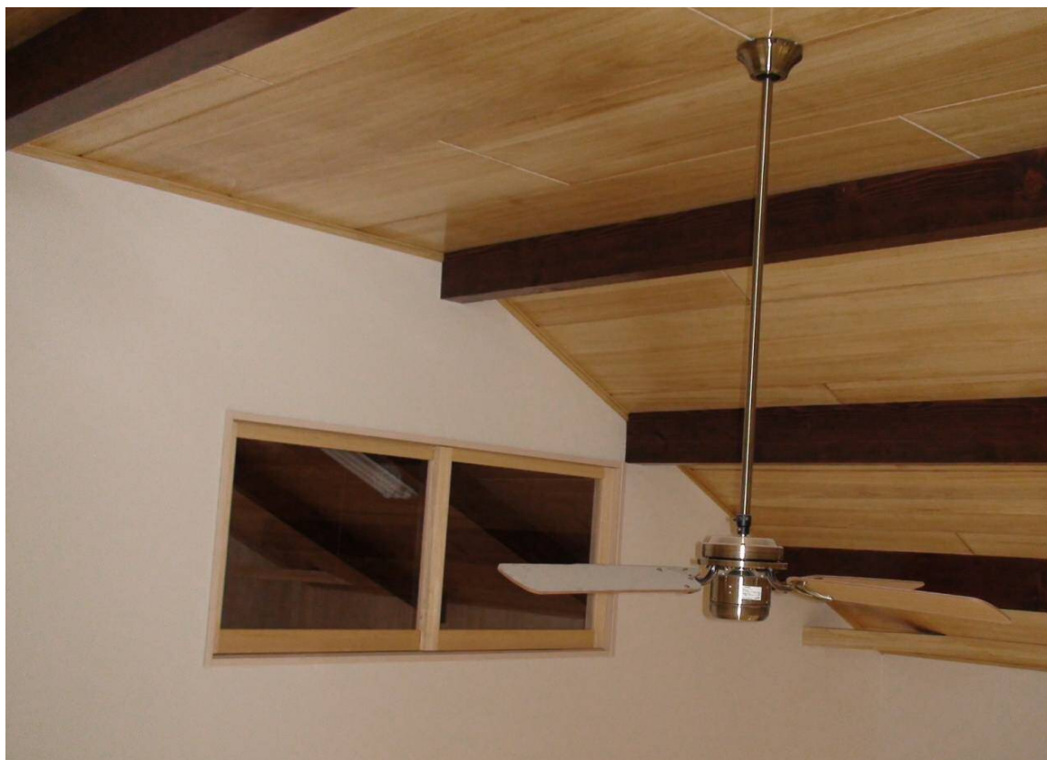
住宅吹抜け用桐材 : 厚12×幅450×長1820/2120/2440mm 塗装(両面)
