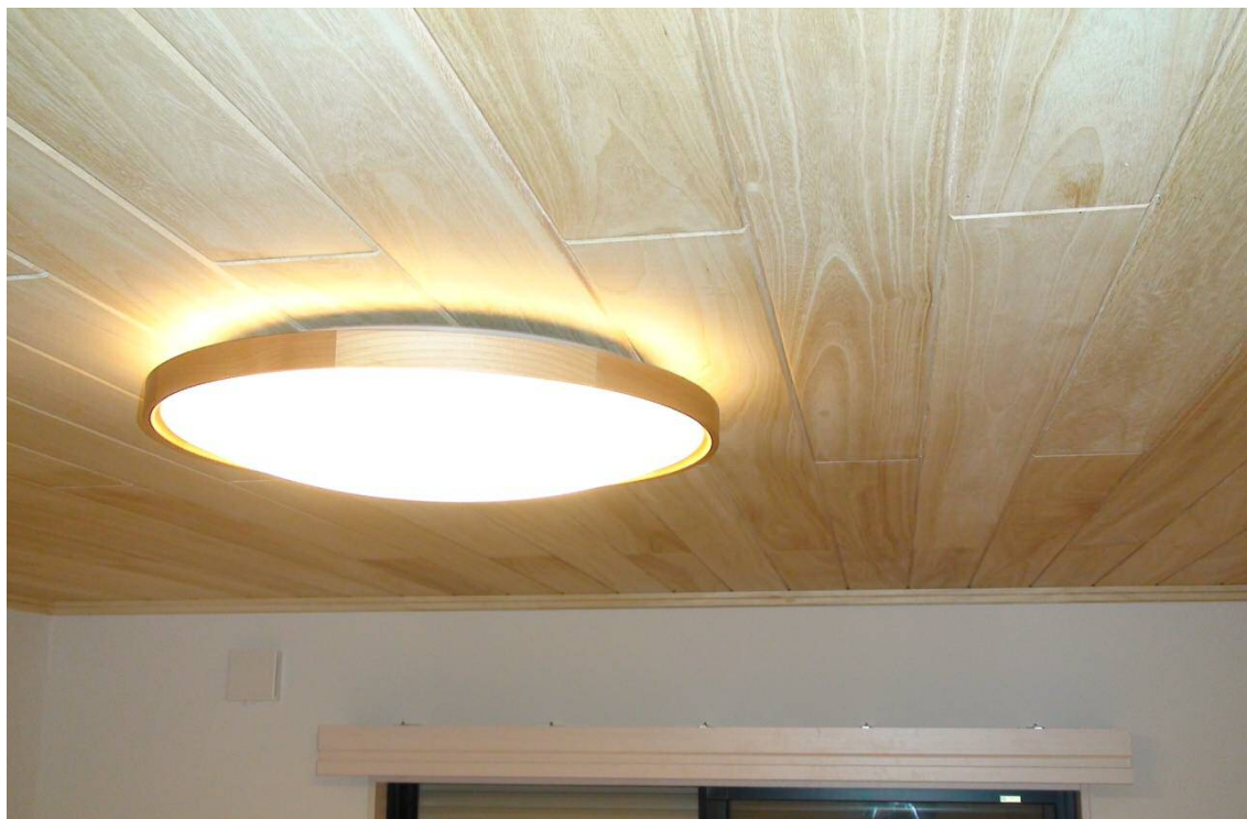
寝室桐天井 : 厚12×幅150×長1820mm 自然塗料塗装(両面) 四方実目透かし 天井裏の湿気防止
