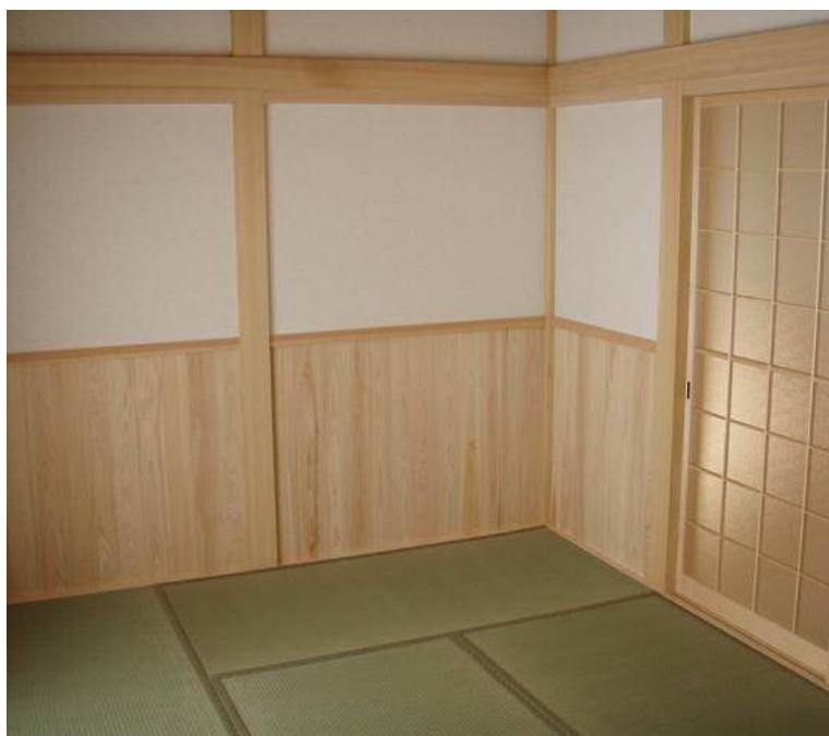
和室桐腰壁 : 厚12×幅150×長1820mm 自然塗料塗装 幅木・笠木付 畳との相性抜群
