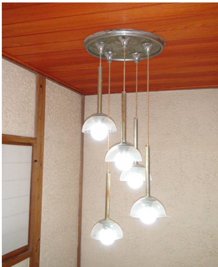
階段桐天井 : 厚12×幅150×長1820mm 自然塗料塗装(両面) 四方実目透かし 天井裏の湿気防止
