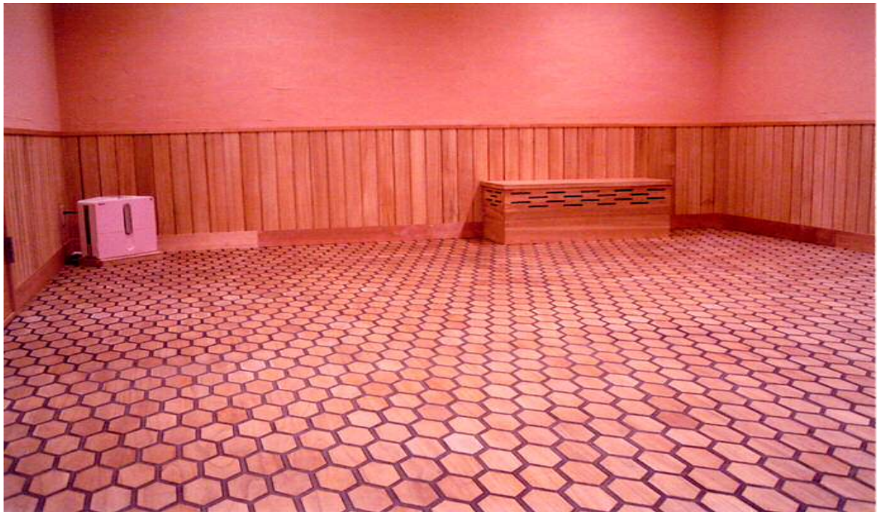
ホルミス温熱特殊ルーム桐床 : 厚12×120mm 亀甲型 2800枚 桐無垢材 自然塗料塗装 モルタルの中に桐亀甲型を埋め込んだ特殊岩盤浴ルーム 桐亀甲型は7年間1枚の割れもなかった 桐腰壁 : 厚12×幅150×長1820mm 自然塗料塗装
