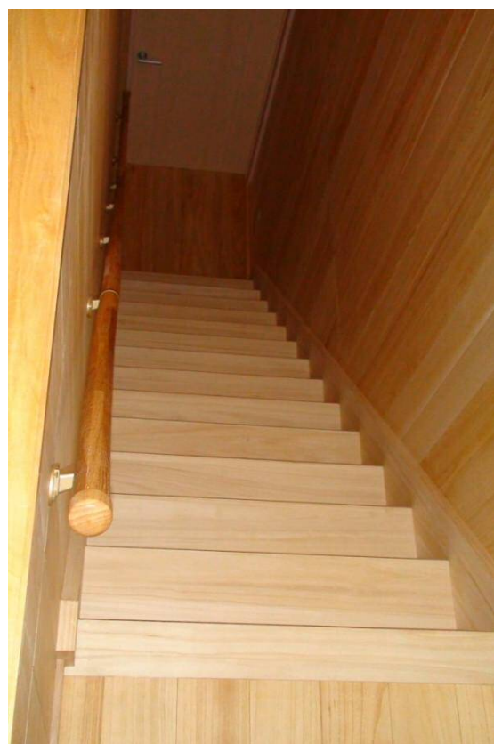
桐階段セット : 桐積層板使用 自然塗料塗装 親 : 厚45×幅250×長4200mm 特注 子 : 厚32×幅260×長2100mm 蹴込 : 厚9×幅250×長900mm 桐壁 : 厚12×幅150×長1820mm 塗装
